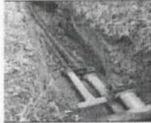
**1.5.- Impulsión Planta Elevadora de Agua Potable Nro.2 PEAP Nro. 2:** La cañería de la impulsión entre el Estanque Bajo y el Estanque Alto, está instalada y probada, faltando la conexión al Estanque Alto. En las partidas eléctricas de fuerza, están ejecutadas la mala de tierra, la postación eléctrica y su respectivo tendido aéreo y se han montado los TF.
