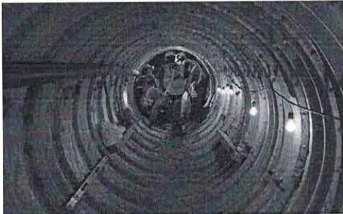
Método constructivo túnel liner
